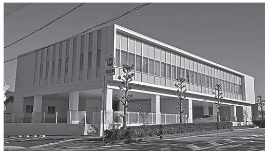
福永海運の新本社社屋
